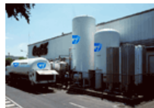
Figura 3.3.5.4.2 – depósitos de H_2 líquido arrefecido.
